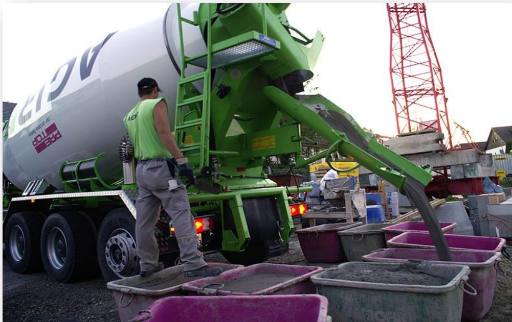
Abbildung: Entladen von Mörtel auf der Baustelle
