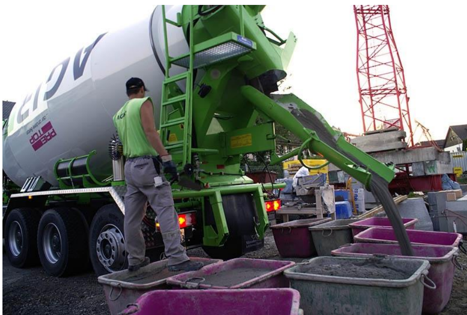
Déchargement de mortier sur le chantier. Photo: Agir
